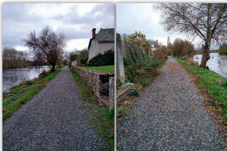
Rénovation du chemin de halage
