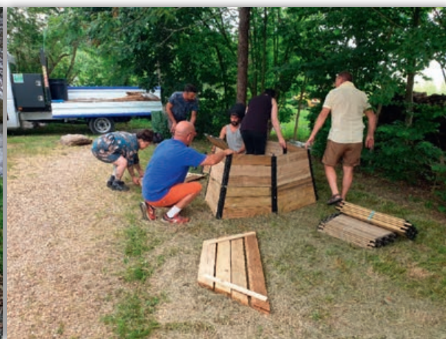
Installation des composteurs collectifs
